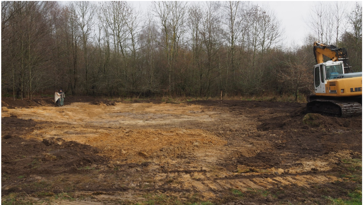
Baggerkuhle für neuen Teich vom November 2025
